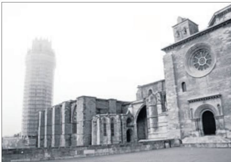
4. Edgar Aldana va retratar les obres del campanar.
