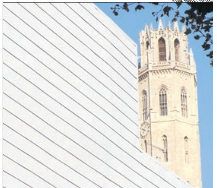
2. Contrast entre la modernitat de l'edifici de la plaça Sant Joan amb el campanar de la Seu.
